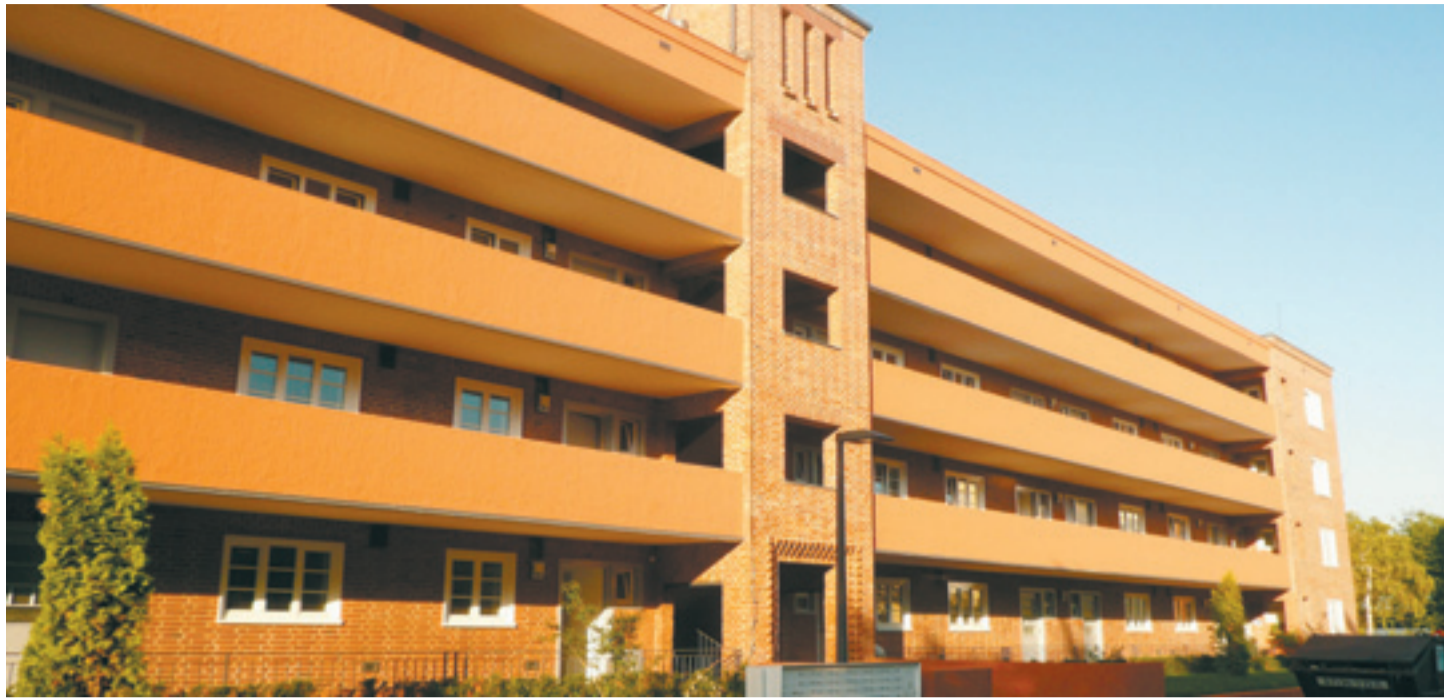
Denkmalschützer registrieren mit Begeisterung, dass Baden-Württembergs einziges Laubenganghaus saniert wurde.
