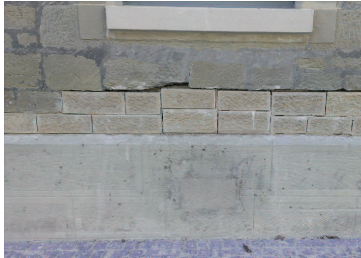
Mauerwerkserneuerung im Sockelbereich.
